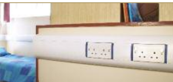
Синие монтажные коробки использованы при монтаже системы кабель-каналов в школе-интернате Old Swinford Hospital School, г. Суинфорд
