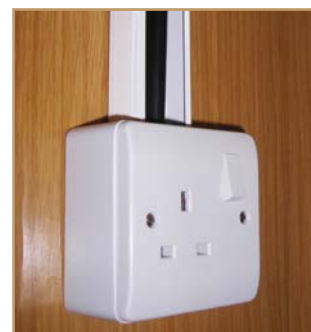
Система MT32, монтируемая по поверхности
